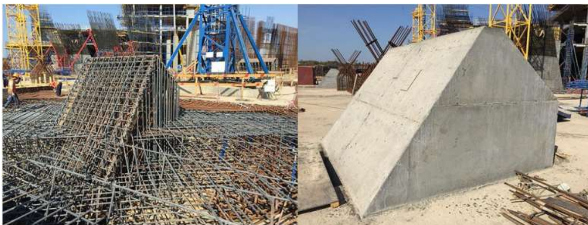
1-rasm. “Samara Arena” futbol stadionining armaturalangan tayanch konstruksiyalari.
