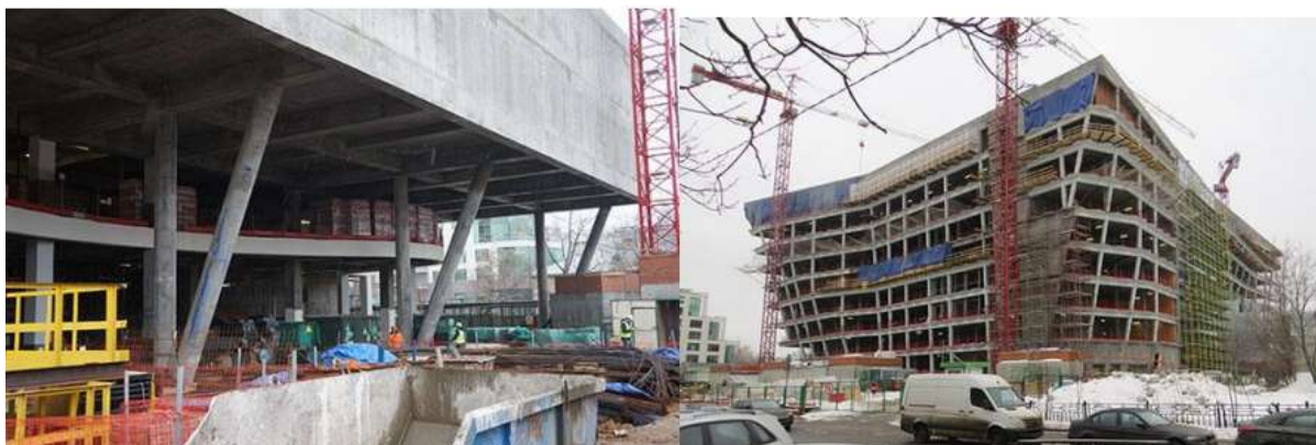
3-rasm. “HTB” telekanali ofis binosi rama-karkasi.
